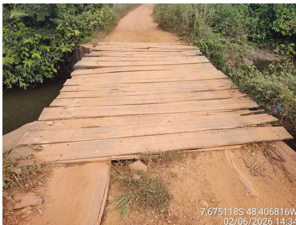
Foto 14: Ponte Mista sobre o Córrego Faz. Grande.
