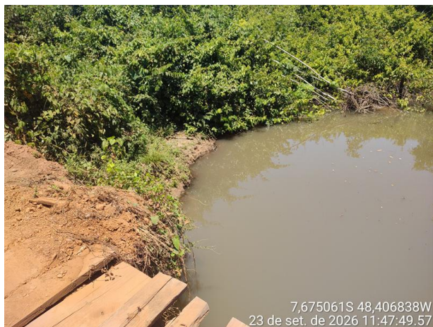
Foto 07: Ponte Mista sobre o Córrego Faz. Grande.
