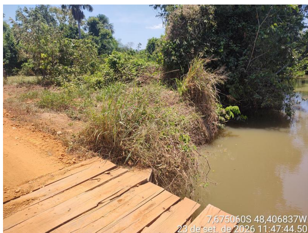
Foto 05: Ponte Mista sobre o Córrego Faz. Grande.
