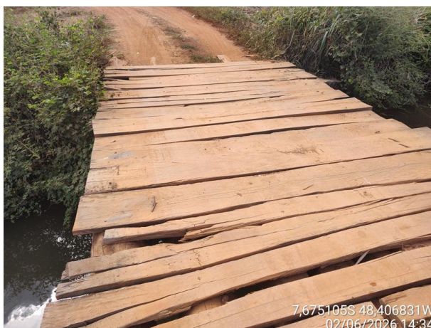
Foto 12: Ponte Mista sobre o Córrego Faz. Grande.
