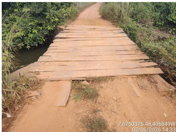
Foto 09: Ponte Mista sobre o Córrego Faz. Grande.
