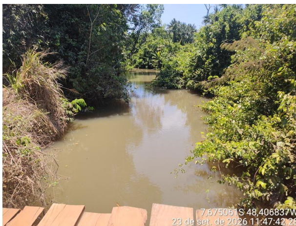
Foto 04: Ponte Mista sobre o Córrego Faz. Grande.
