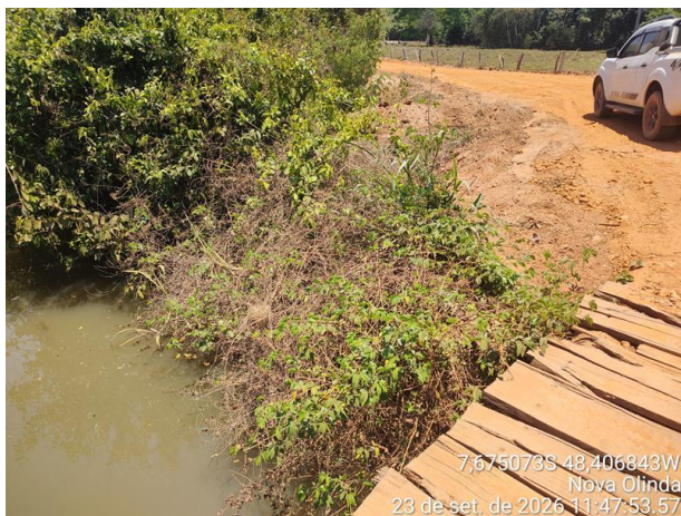
Foto 08: Ponte Mista sobre o Córrego Faz. Grande.
