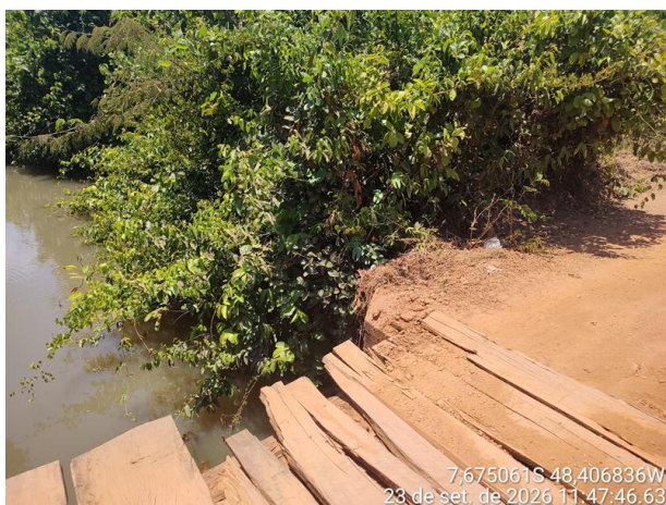
Foto 06: Ponte Mista sobre o Córrego Faz. Grande.
