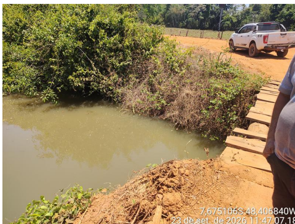
Foto 02: Ponte Mista sobre o Córrego Faz. Grande.
