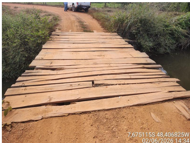
Foto 13: Ponte Mista sobre o Córrego Faz. Grande.
