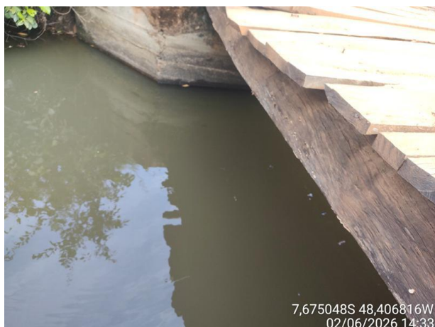
Foto 11: Ponte Mista sobre o Córrego Faz. Grande.
