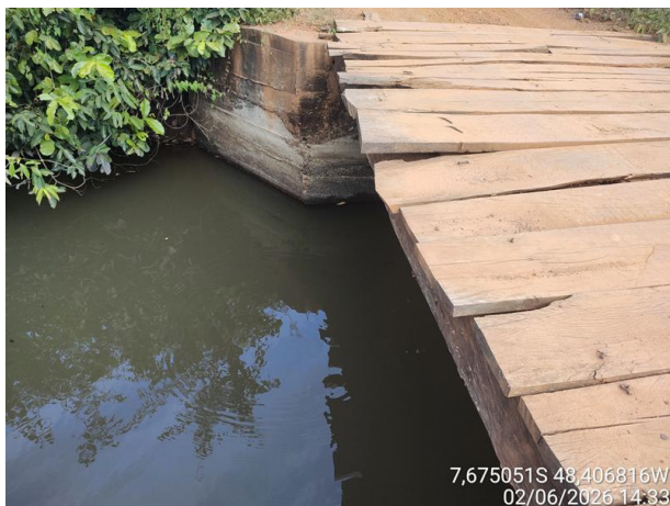
Foto 10: Ponte Mista sobre o Córrego Faz. Grande.
