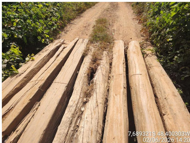
Foto 08: Ponte sobre o Córrego Curador.
