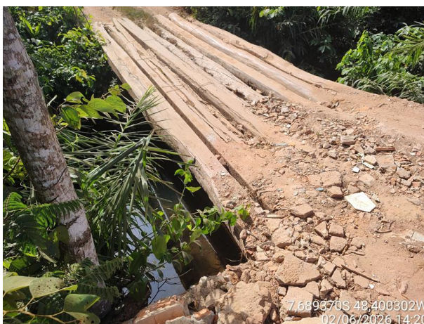
Foto 02: Ponte sobre o Córrego Curador.
