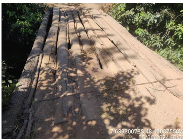
Foto 12: Ponte sobre o Córrego Curador.
