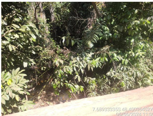
Foto 14: Local da nova Ponte do Córrego Curador.
