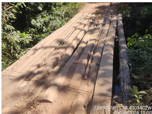
Foto 11: Ponte sobre o Córrego Curador.
