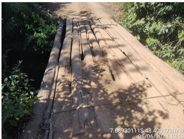
Foto 10: Ponte sobre o Córrego Curador.
