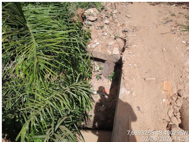
Foto 07: Ponte sobre o Córrego Curador.
