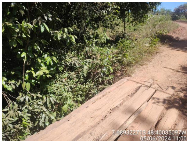
Foto 09: Ponte sobre o Córrego Curador.
