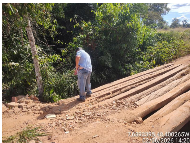
Foto 05: Ponte sobre o Córrego Curador.
