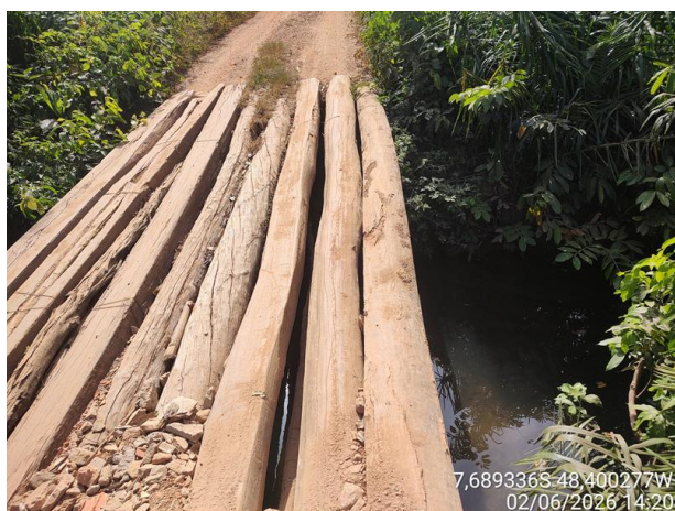
Foto 03: Ponte sobre o Córrego Curador.
