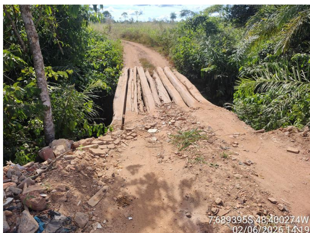
Foto 01: Ponte sobre o Córrego Curador.
