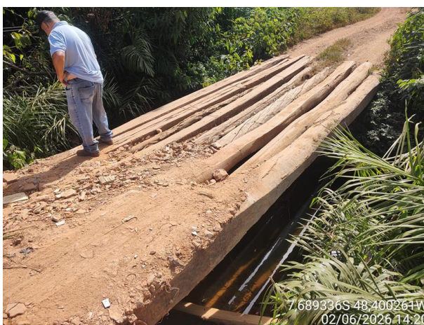
Foto 04: Ponte sobre o Córrego Curador.
