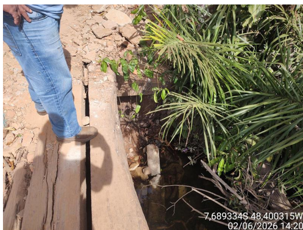
Foto 06: Ponte sobre o Córrego Curador.
