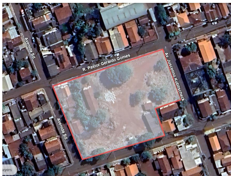
Figura 1: Área de localização da Construção da Feira Coberta.
