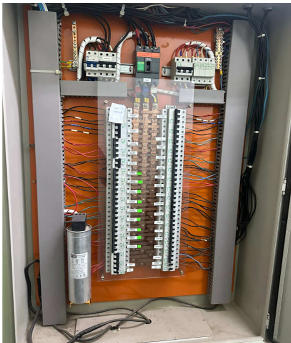
Figura 4 - Principal QDC da área administrativa da Câmara Municipal. Ligações de Ar-condicionado junto ao circuito de iluminação.
