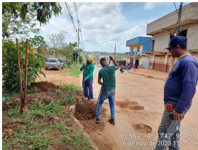
LIMPEZA BOCA DE LOBO RUA 59
