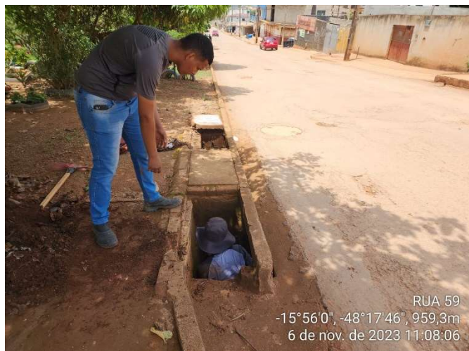
LIMPEZA BOCA DE LOBO RUA 59
