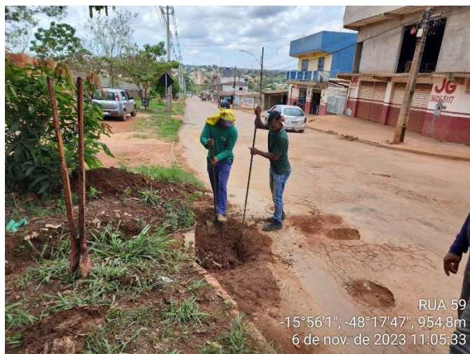
LIMPEZA BOCA DE LOBO RUA 59
