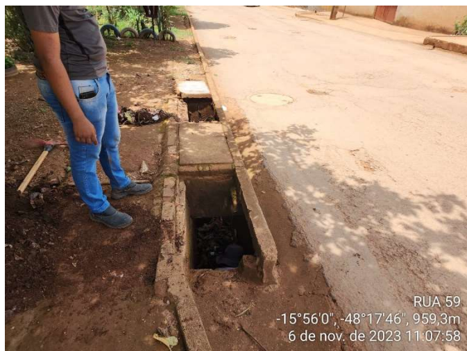
LIMPEZA BOCA DE LOBO RUA 59
