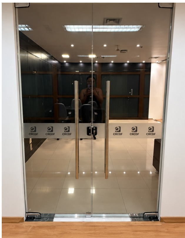
Figura 4 – Referência da porta de acesso à 2ª Recepção com faixa horizontal de identificação visual.
