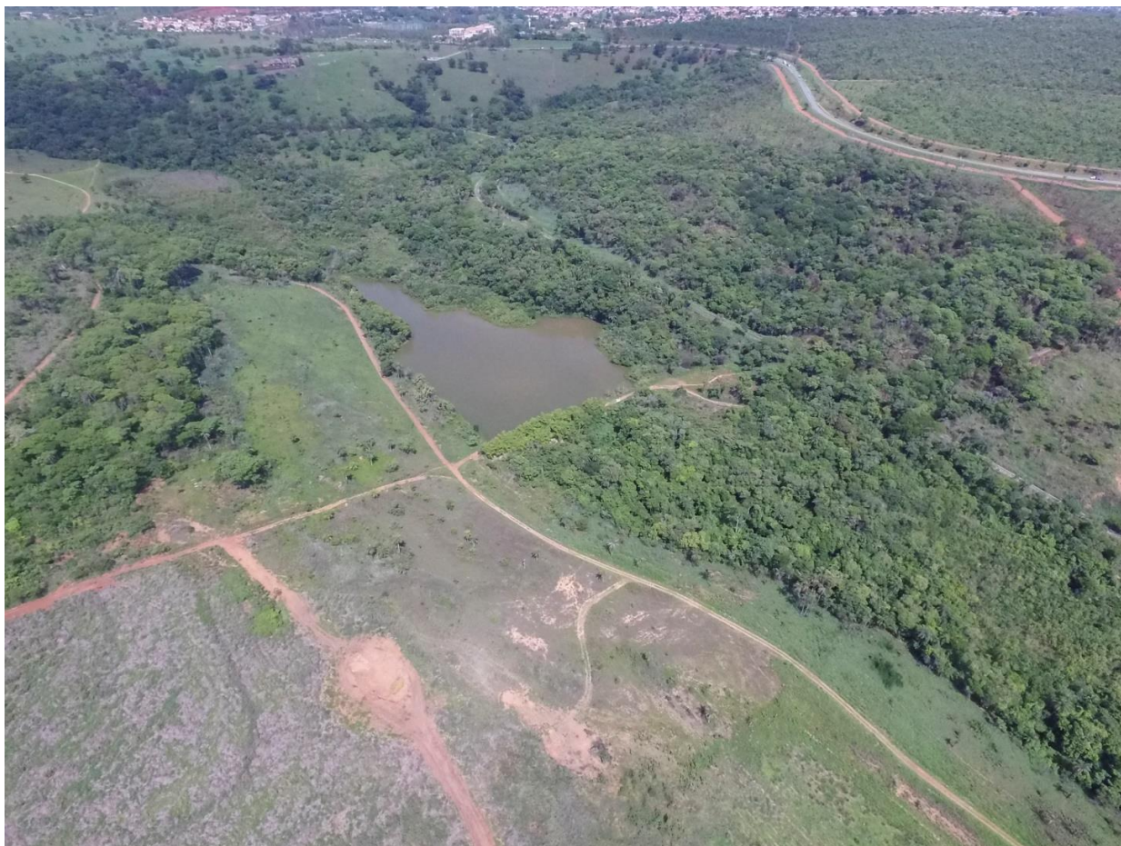
Figura 3 - Fotografia Ilustrativa da Barragem
