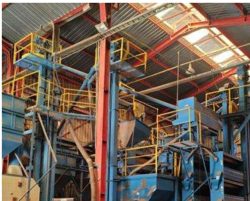
Figura 1 — Vista geral da área de intervenção — conjunto de elevadores, plataformas e estruturas de transporte e classificação da UBS. Referência de ângulo para o registro "antes x depois".
