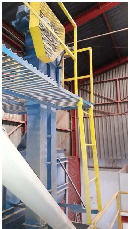
Figura 4 — Elevador de canecas com plataforma e escada — exemplo de frente de trabalho em altura. O fiscal observa do piso: cinto conectado, área inferior isolada e movimentação controlada de peças.
