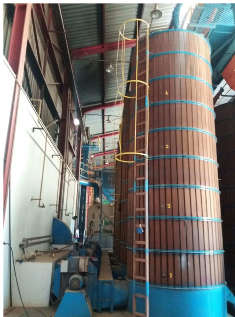
Figura 5 — Secador vertical de sementes — estrutura que NÃO integra o desmanche e deve permanecer intacta. Conferir também as escadas fixas verticais adjacentes e seus sistemas de proteção contra quedas (Anexo III da NR-12 e Anexo III da NR-35).
