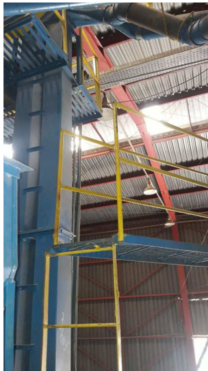
Figura 2 — Passarelas e guarda-corpos adjacentes à área de desmanche. O fiscal deve conferir diariamente que o isolamento impede acesso de pessoas não autorizadas sob a área de trabalho.
