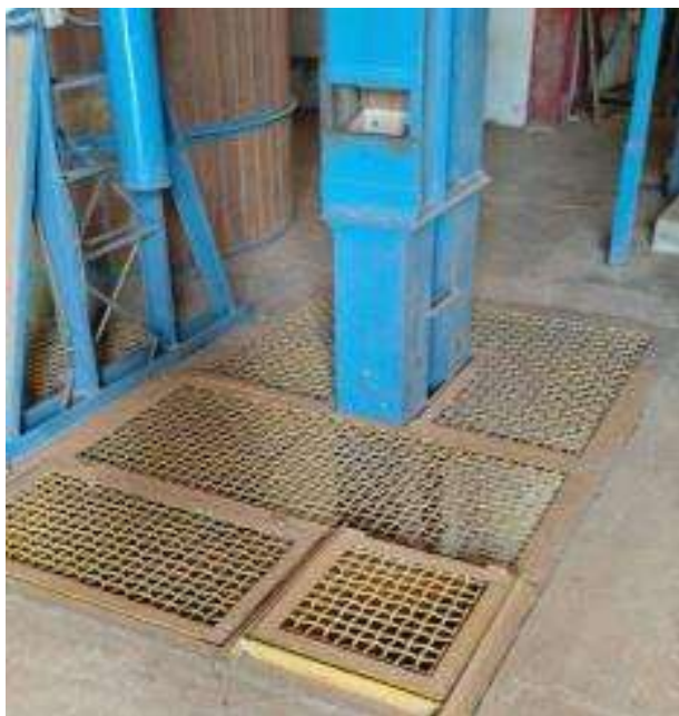
Figura 6 — Fossos gradeados dos elevadores. Durante e após o desmanche, as aberturas de piso devem permanecer 100% cobertas por grades ou chapas — abertura descoberta é motivo de suspensão imediata.
