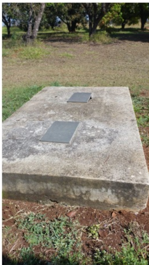
Figura 2 – vista externa da caixa/poço de visita (PV) que atende o restaurante do CNPMS — 26/08/2026.
