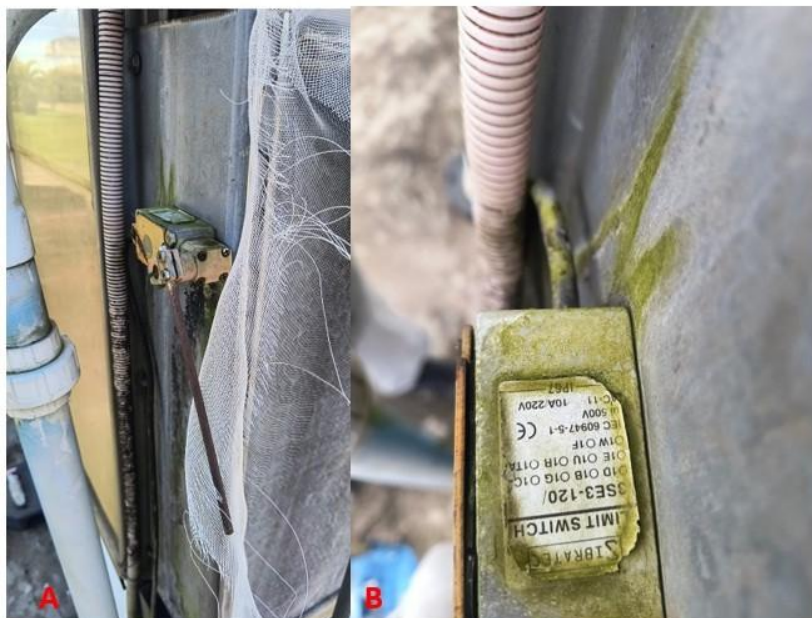
Figura 23 – Fotos A e B detalhe do fim de curso do sistema de resfriamento (Liga/desliga).
