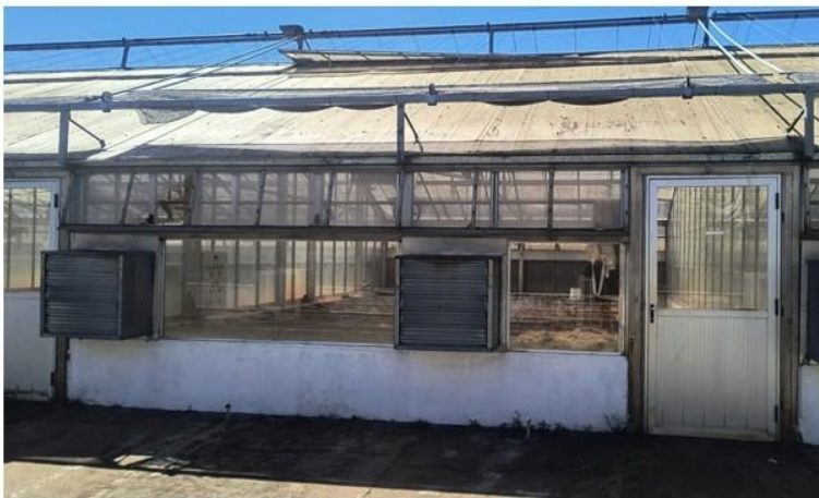
Figura 13 – Compartimento 03 – detalhe entrada pela lateral esquerda.
