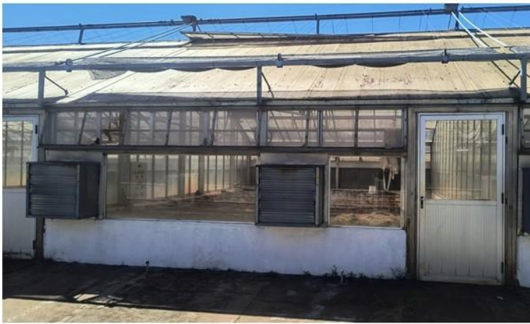
Figura 13 – Compartimento 03 – detalhe entrada pela lateral esquerda.
