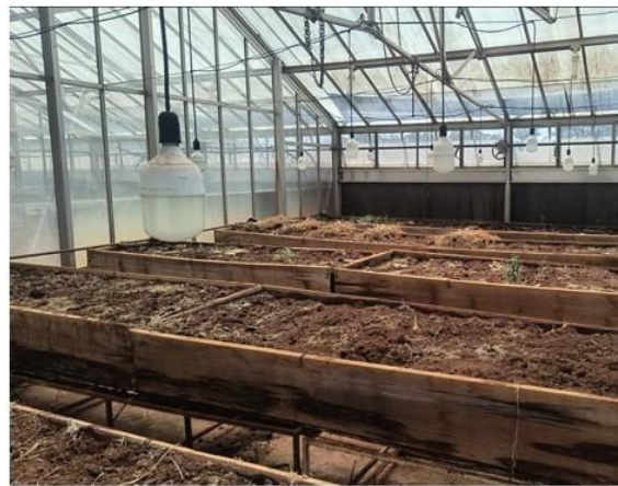
Figura 18 – Compartmento 04 – foto interna (a).
