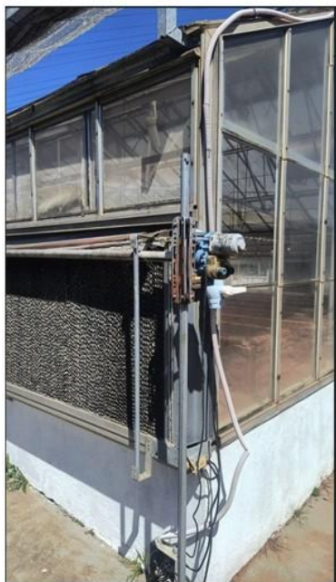
Figura 21 – detalhe do sistema de abertura e fechamento da cortina de proteção e acionamento do sistema de resfriamento (4 sistemas – um para cada compartimento)
