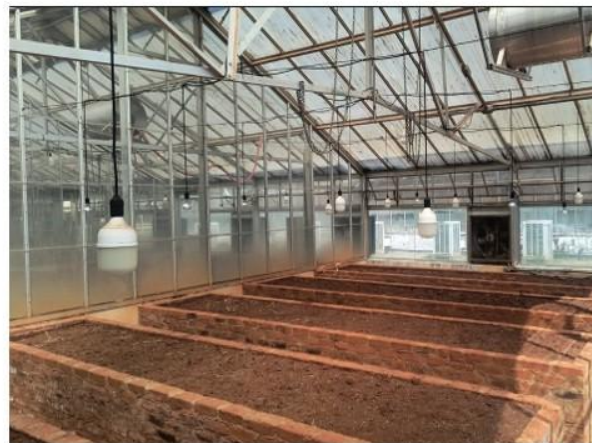
Figura 06 – Compartmento 01 – foto interna (a)
