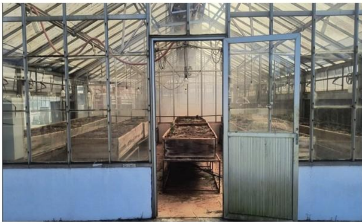
Figura 17 – Compartmento 04 – detalhe entrada pela frente (rua).
