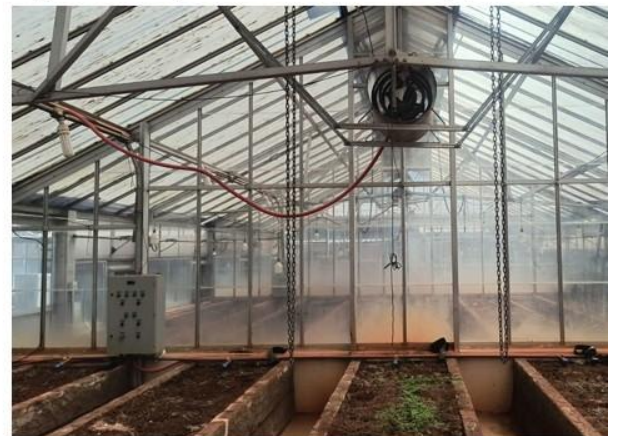
Figura 16 – Compartimento 03 – foto interna (c).
