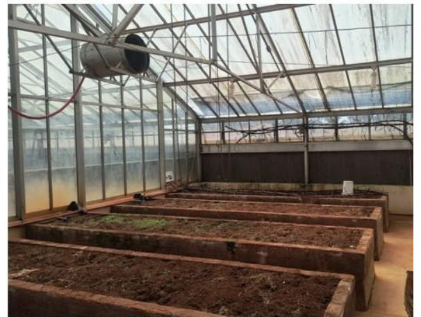
Figura 14 – Compartimento 03 – foto interna (a).
