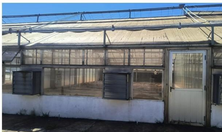
Figura 9 – Compartmento 02 – detalhe entrada pela lateral esquerda.
