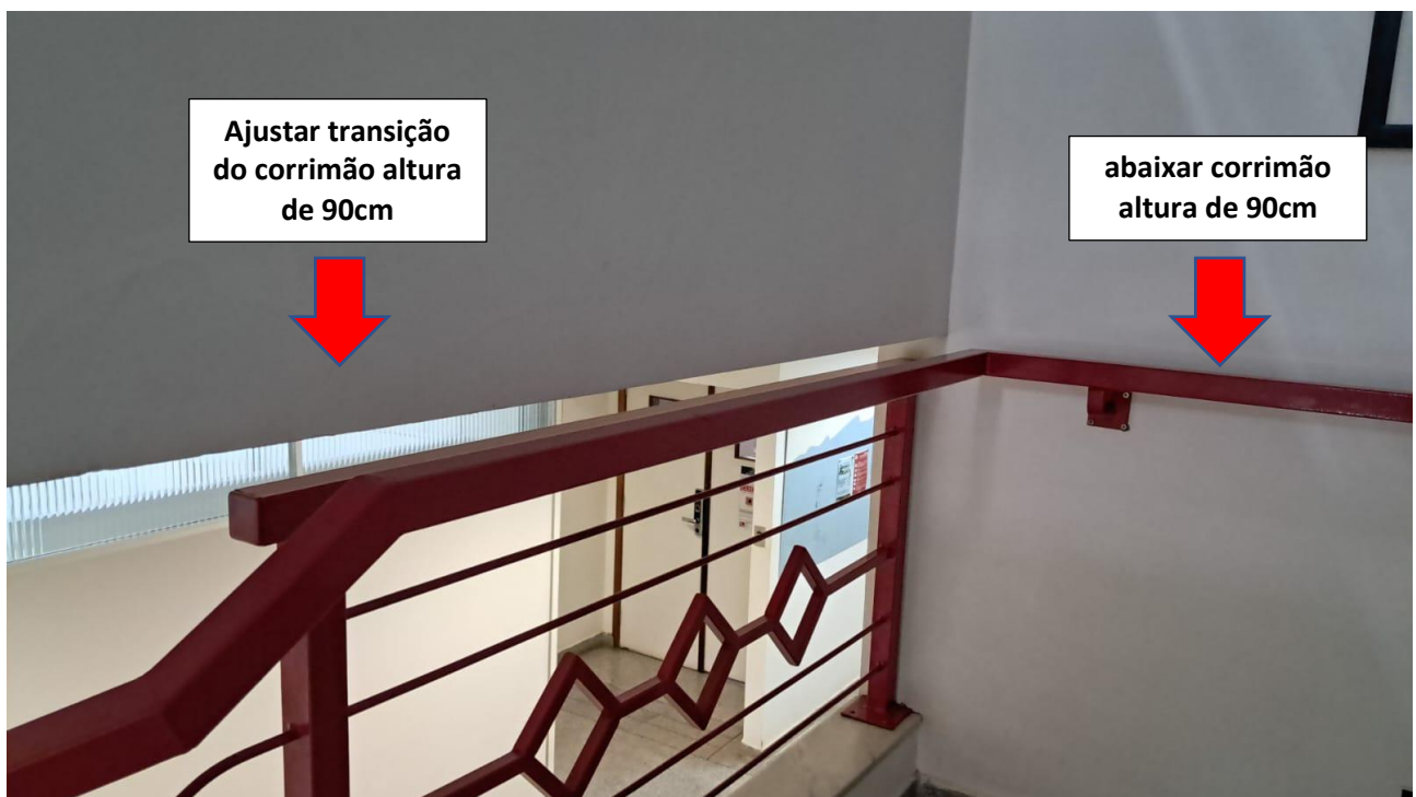
Detalhe do 1º para o 2º pavimento.
