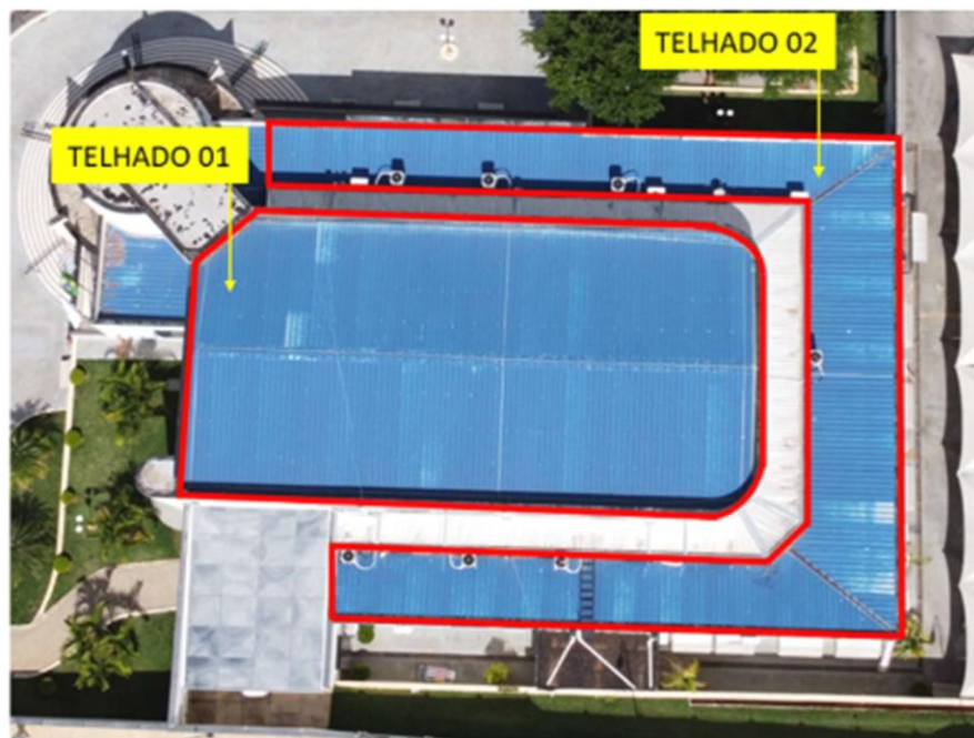
Figura 1 - Imagem aérea do local
