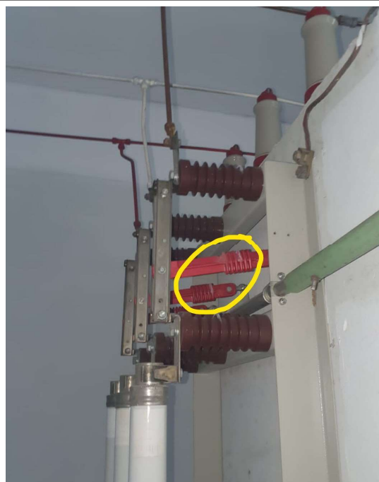
Figura 2: Chave seccionadora tripolar com 15kV e base para fusível
