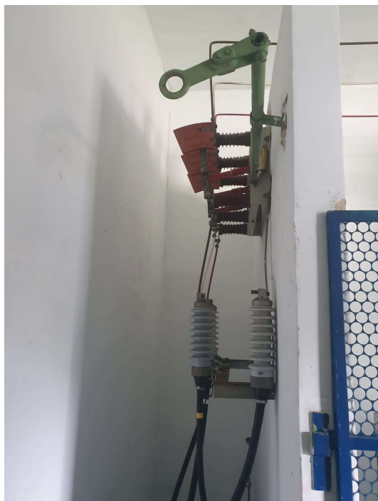
Figura 3: Chave seccionadora tripolar com 15kV sem base para fusível
