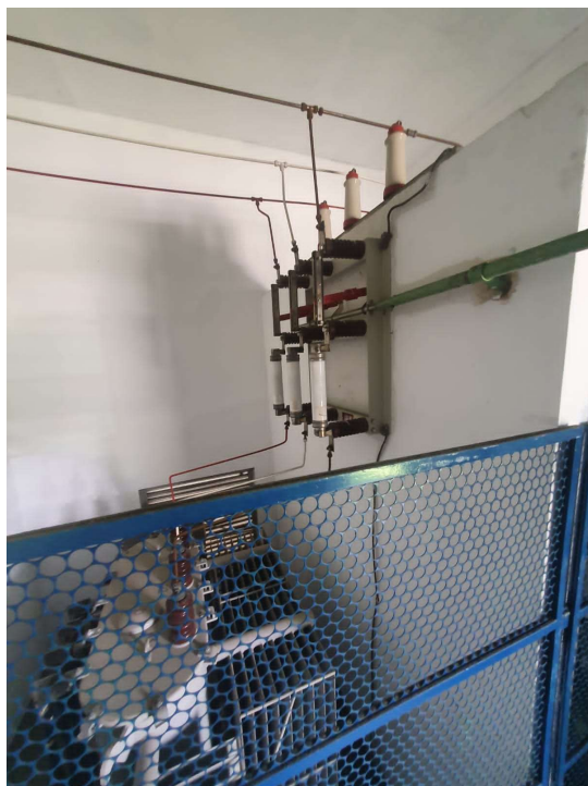
Figura 1: Chave seccionadora tripolar com 15kV e base para fusível
