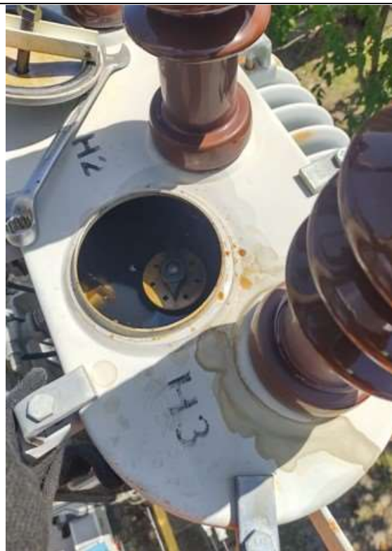
Imagem 8: Transformador 45 kVA da SPROT.
