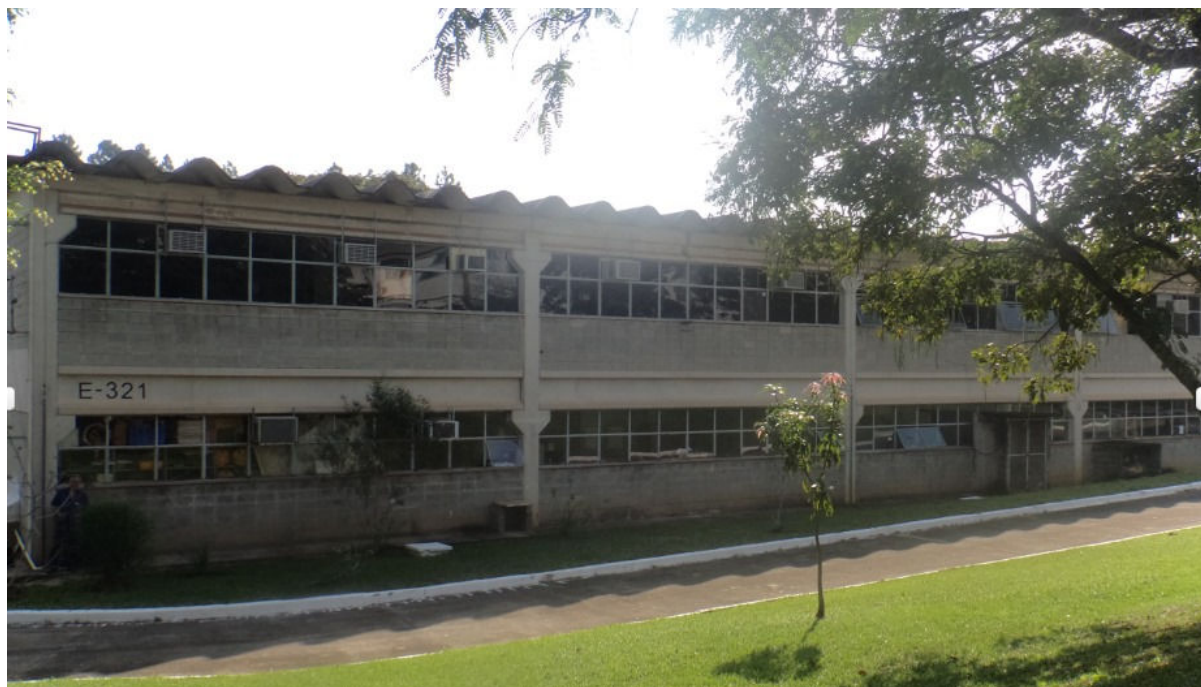
Fig. 01 – Fachada do prédio onde está localizada a área
