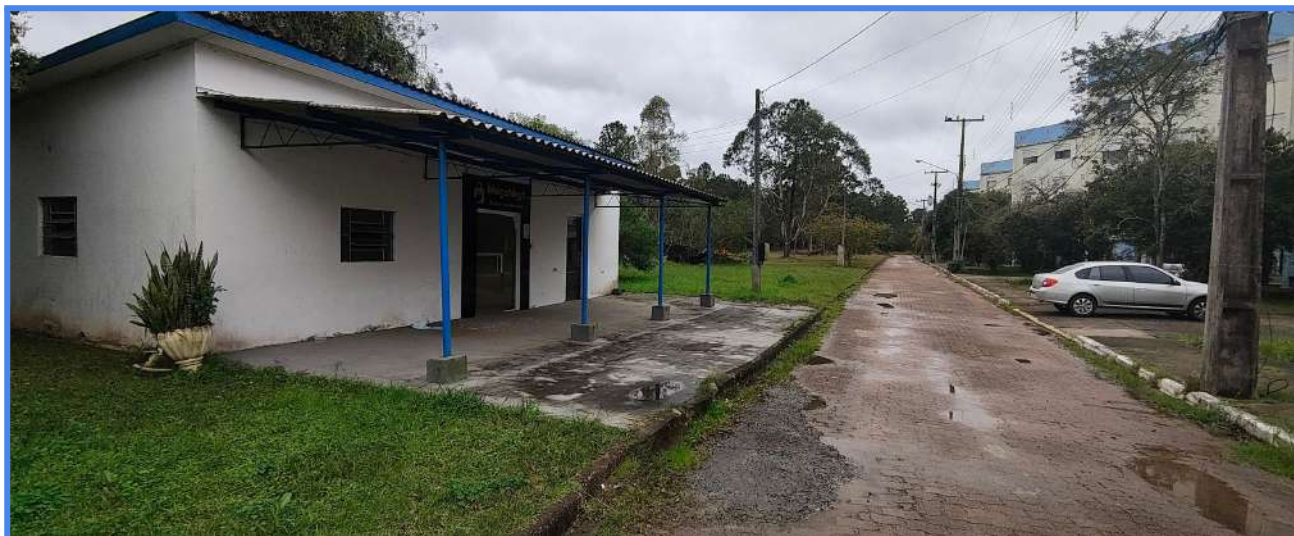
Foto 01 – Vista rua acesso à edificação
