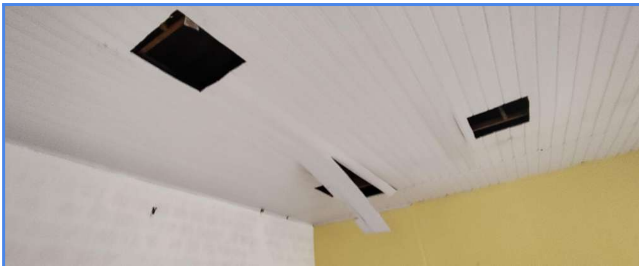
Foto 08 - Detalhe do forro de pvc
