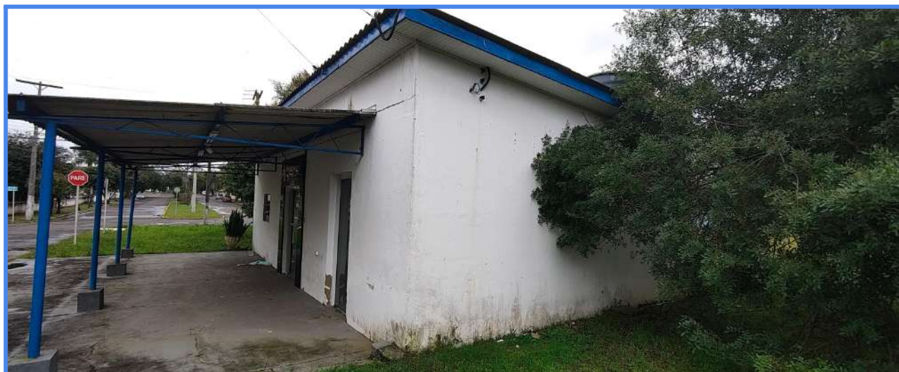
Foto 04 –Vista lateral edificação
