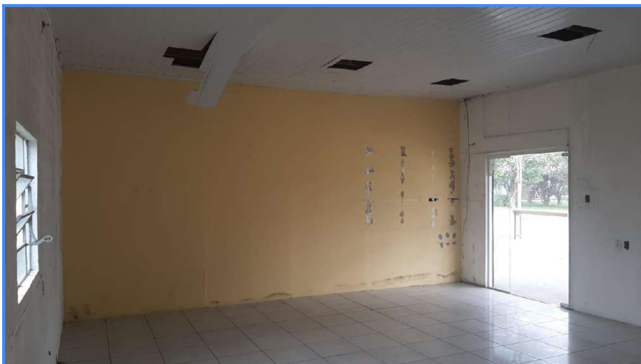
Foto 06 – Vista interna para porta acesso
