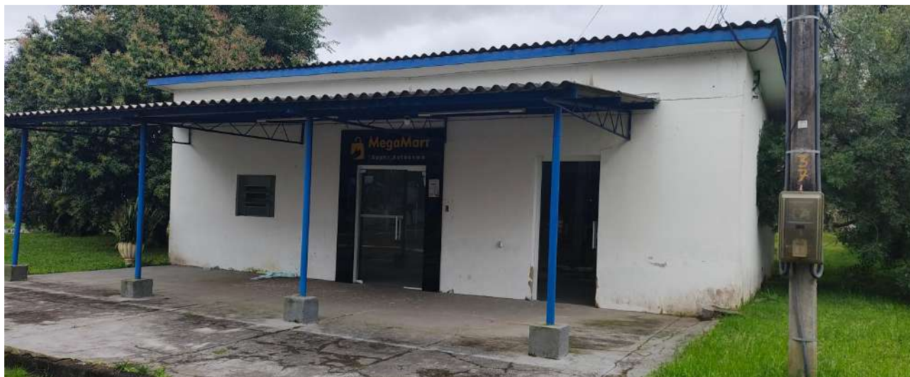
Foto 02 – Fachada frontal edificação
