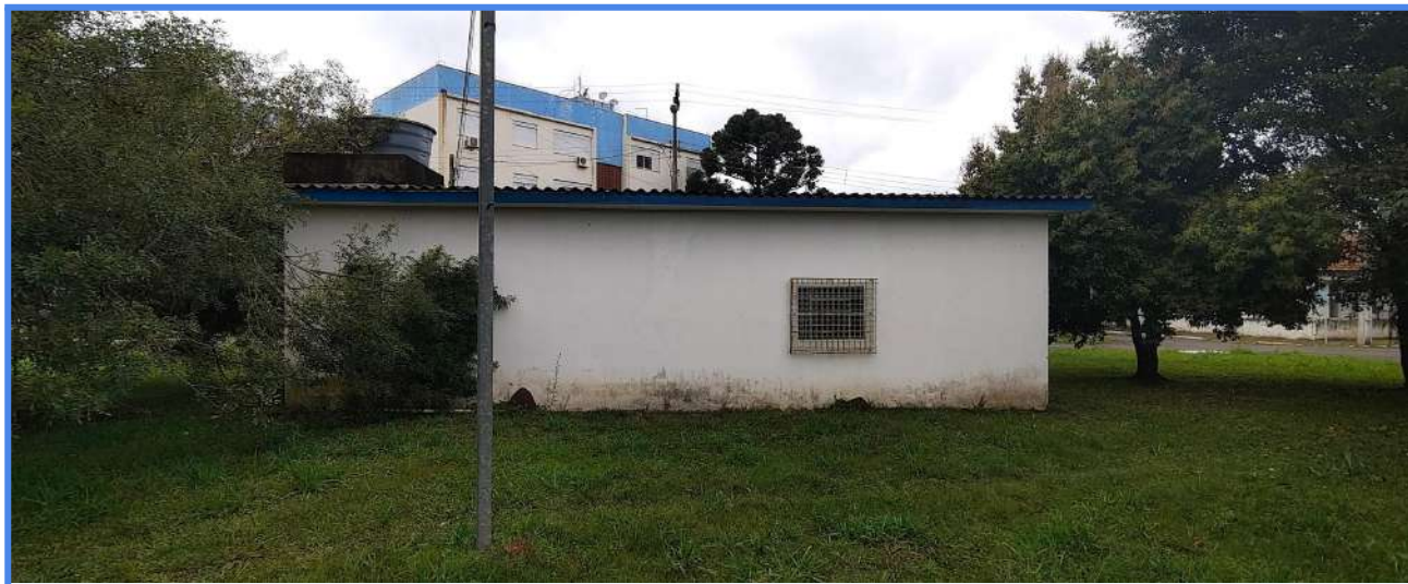
Foto 03 – Fachada fundos edificação
