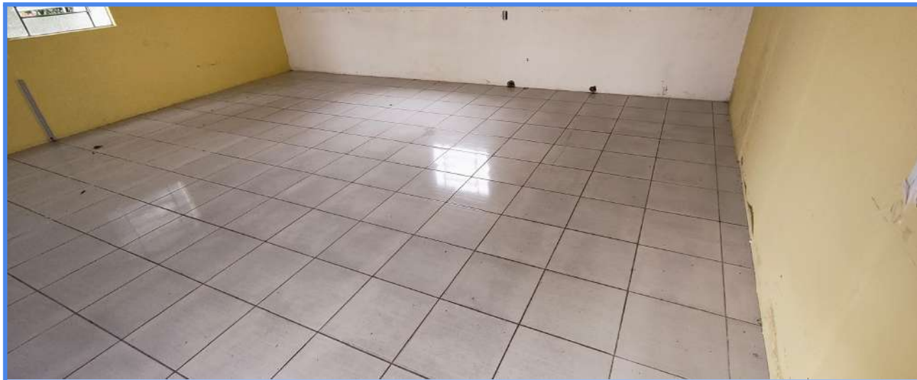
Foto 07 – Detalhe do piso
