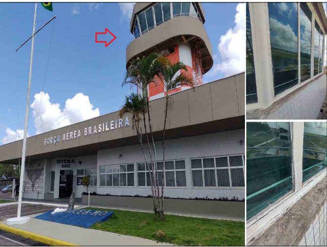
SERVIÇO DE RECUPERAÇÃO DAS MOLDURAS METÁLICAS
