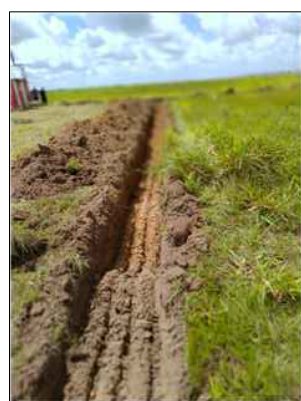
Escavação da Vala
