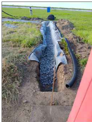
Instalação do Dreno
