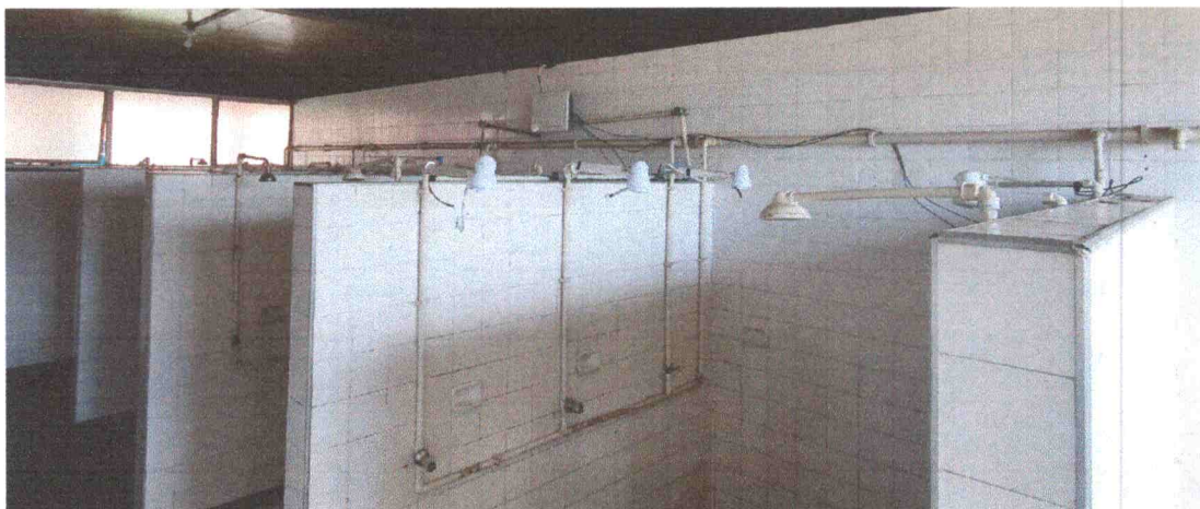
Anexo Fotográfico 1: Situação atual do Banheiro.
