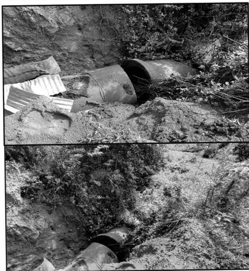
Fotos 02 e 03: manilhas em bom estado.
