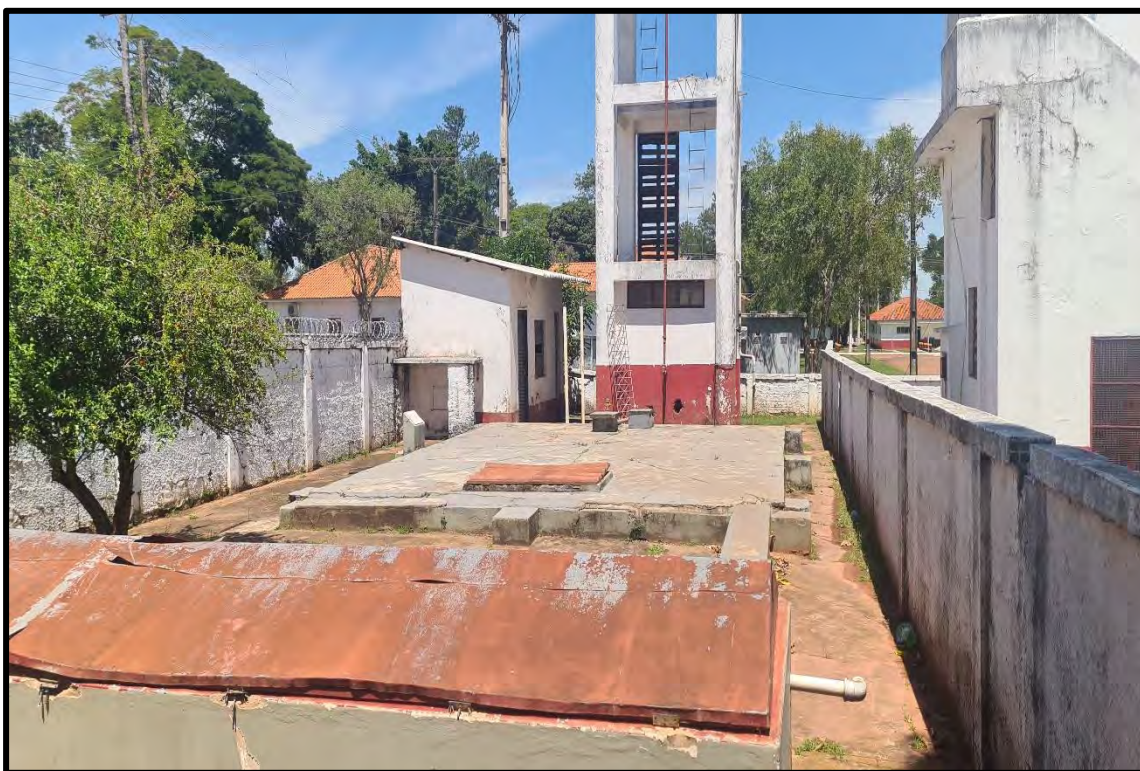
Figura 1 – Sistema de Tratamento de Água do 17º RCMec
