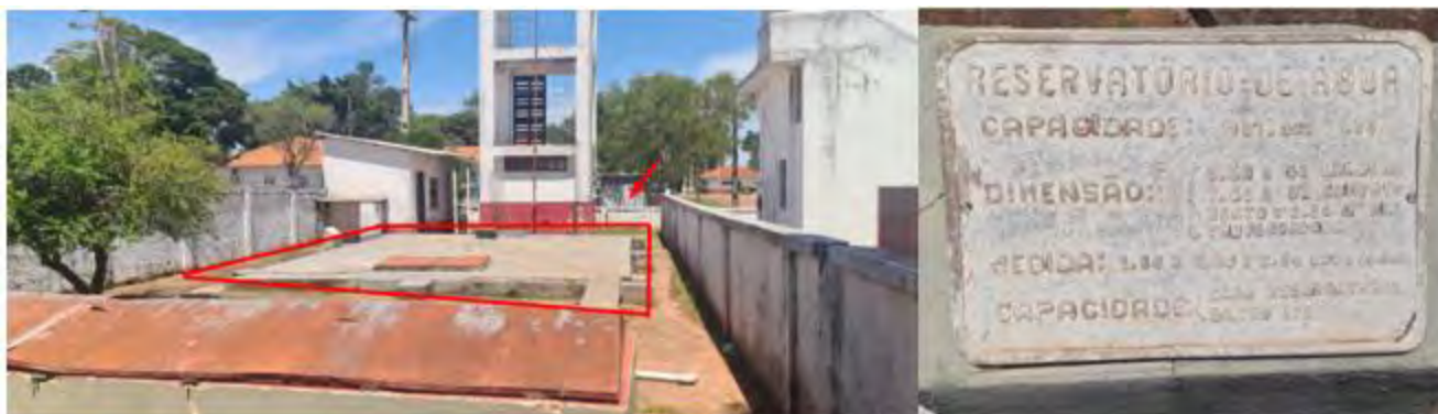
Figura 3 Reservatório de água do 17° RC Mec
