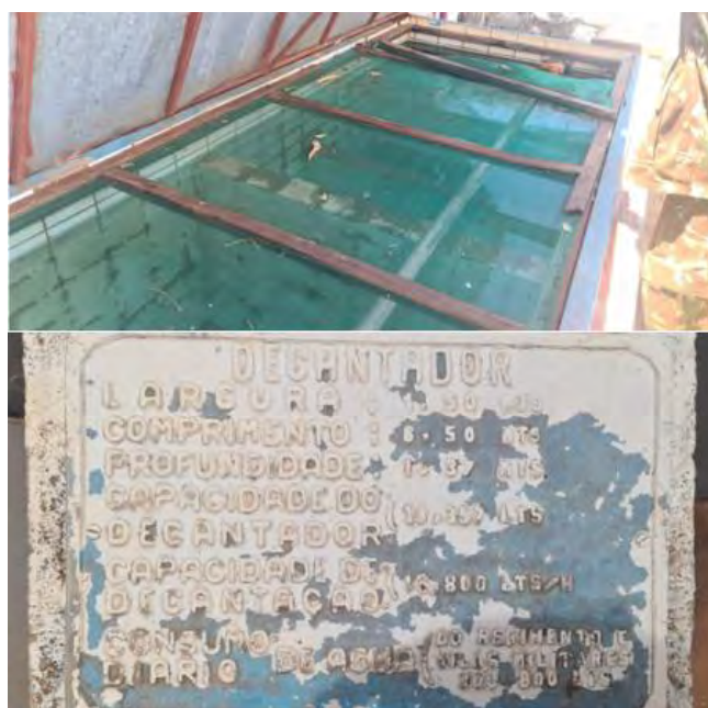
Figura 4 Decantador do 17° RC Mec
