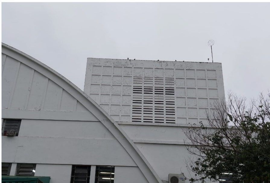
Foto 01 – Fachada Pavilhão Produtora
