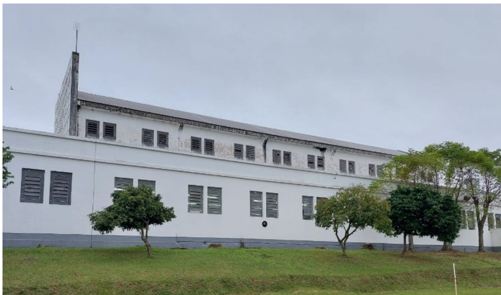
Foto 02 – Fachada Lateral Esquerda Pavilhão Produtora
