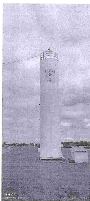
Foto 2: Caixa D'Água "2" 60 mil litros(Gd Quartel)
