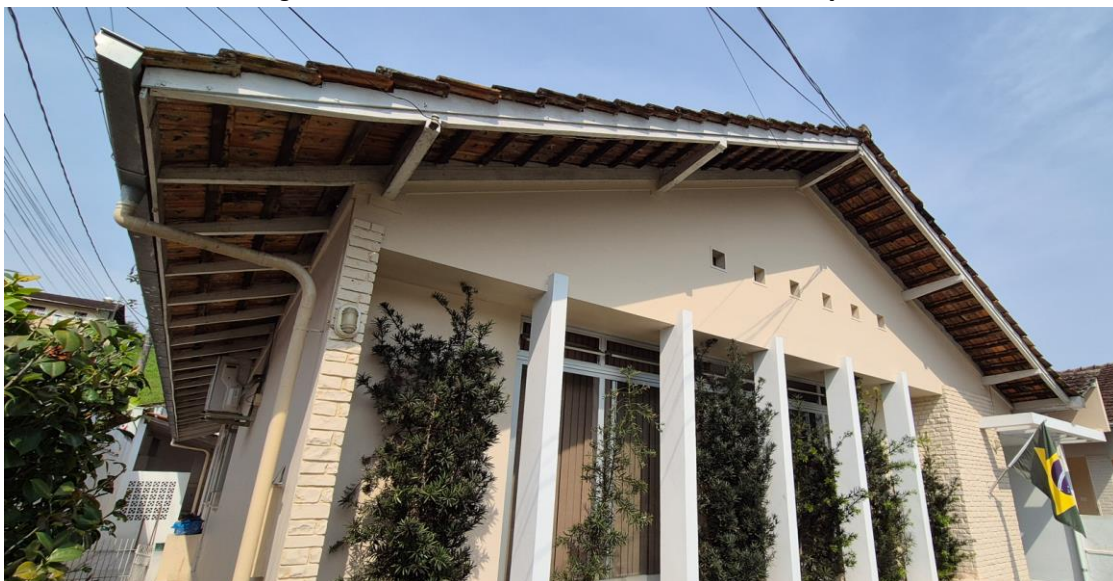
Figura 12: Cubículos Visão Geral da Frente da Edificação
