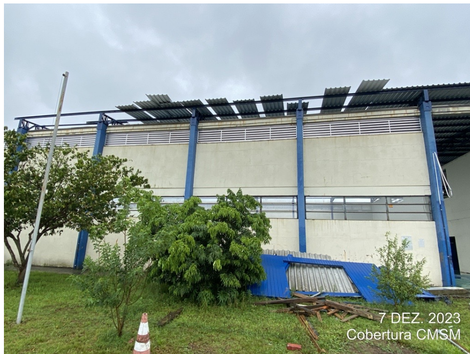
Figura 03 – Vista do telhamento em construção
