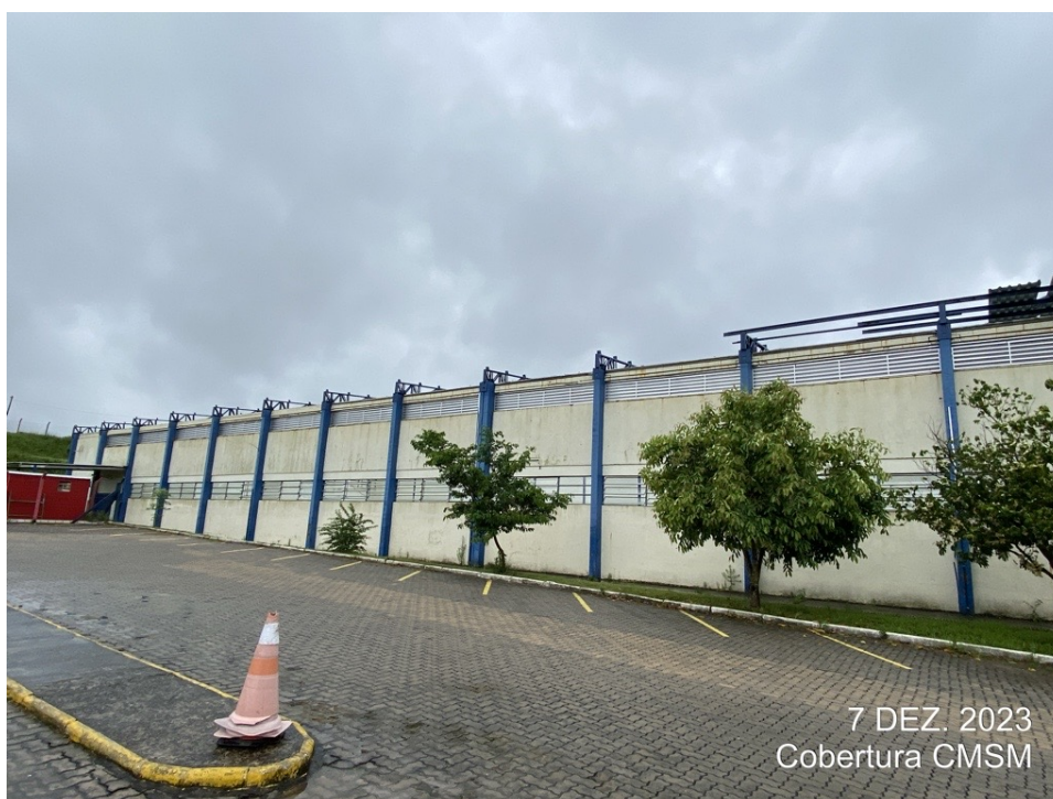
Figura 02 – Vista dos vãos
