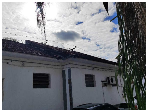
Foto 003 – Telhado do alojamento Cb/SD
