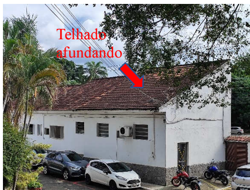
Foto 002 – Telhado do alojamento Cb/SD
