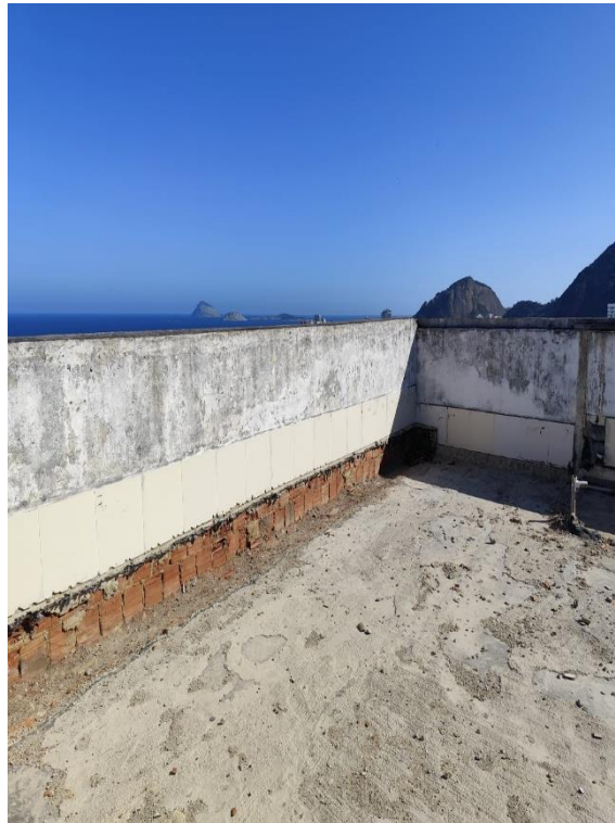
Foto 3 – Remoção de material excessivo
