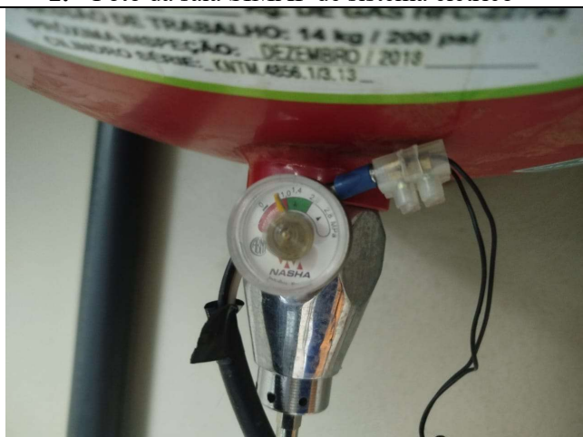
4. Foto da sala SIMAF conexão elétrica solta
