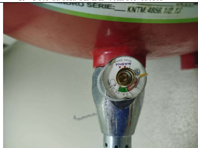
3. Foto da sala SIMAF manômetro quebrado
