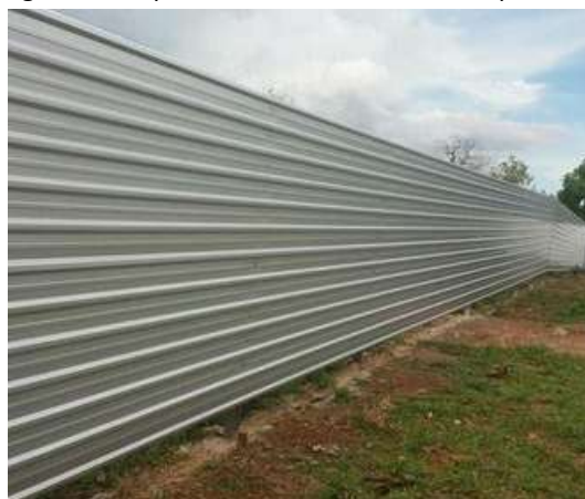
Figura 5 – Tapume com telha metálica trapezoidal
