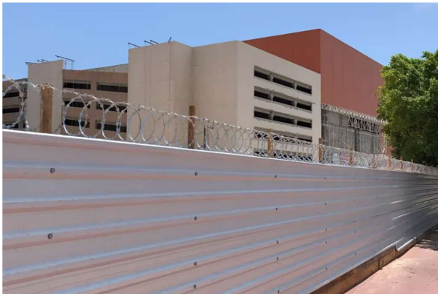
Figura 6 - Concertina instalada sobre tapume.
