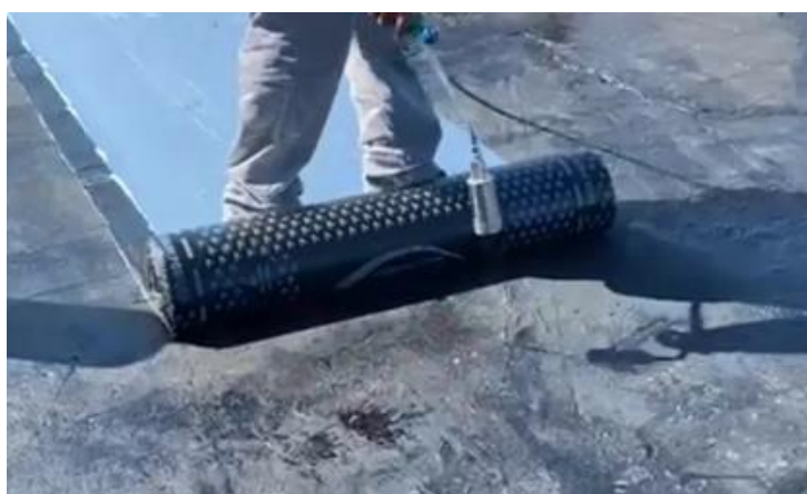
Figura 22- Aplicação da manta asfáltica com utilização de maçarico.
