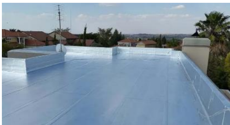
Figura 21- Laje impermeabilizada com manta asfáltica com face superior aluminizada.
