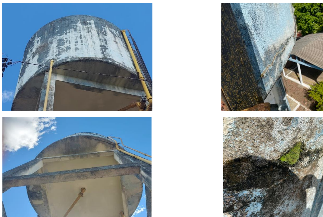
Figura 01 – Algumas situações típicas para tratamento de trincas, rachaduras e imperfeições.
