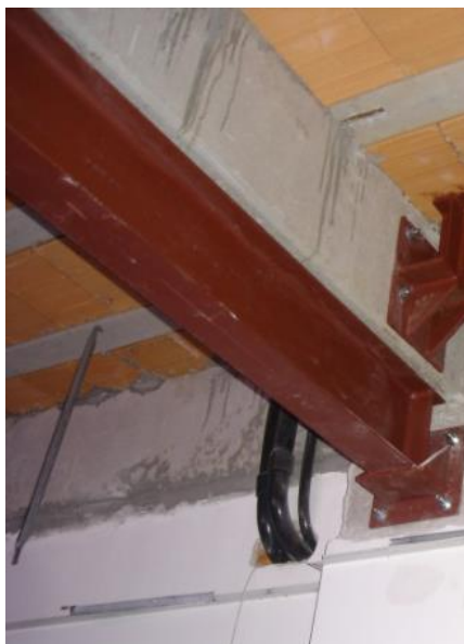
Figura 03 – Modelo de reforço de viga de concreto armado com utilização de viga metálica.
