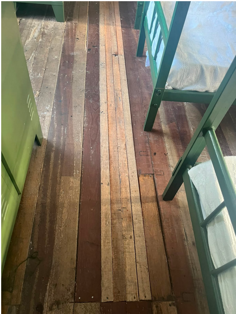
ITEM 04 - Piso de madeira, assoalho, Aloj Sd EP Bia Cmdo:
