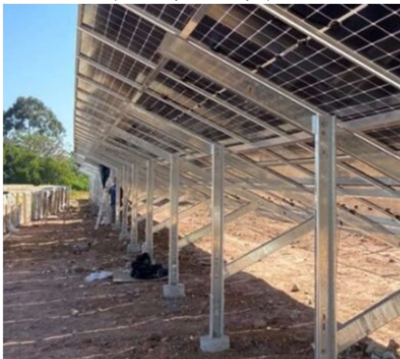
Exemplo de solução de fundação profunda
