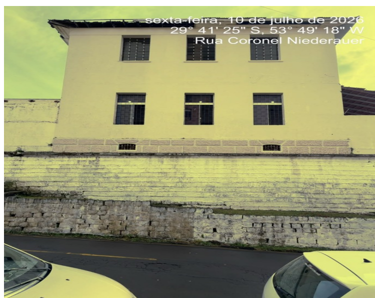
Figura 1 – Vista da Fachada Sul do Pav Alojamento
