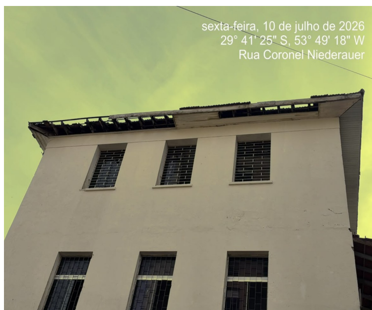
Figura 2 – Vista aproximada do beiral e telhas a serem substituídos
