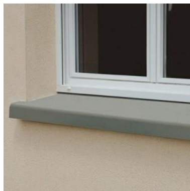
Foto 47: Peitoril de concreto
