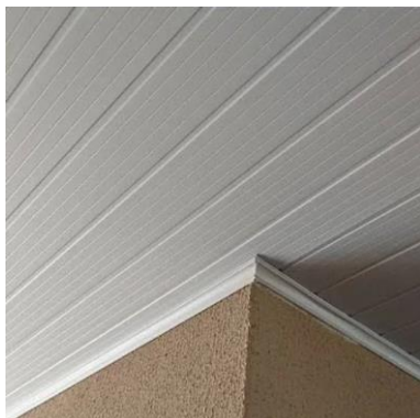
Foto 38: Rebaixamento de Forro PVC
