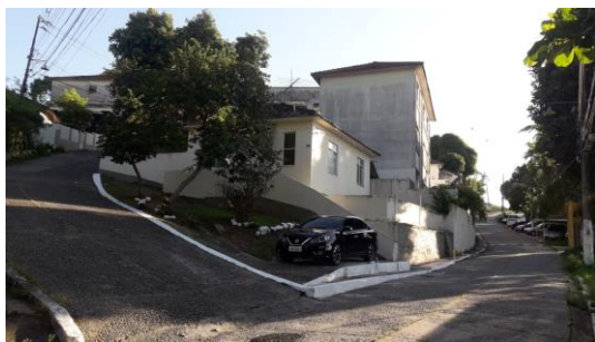
Foto 1 – Fachada da VMC
