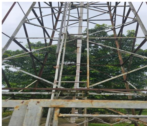
Imagem 6: vista da escada e estrutura existente.
