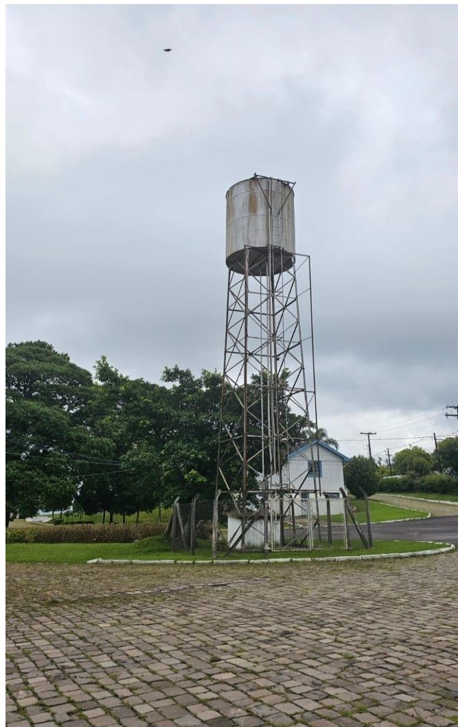
Imagem 1: visão geral da caixa d'água
