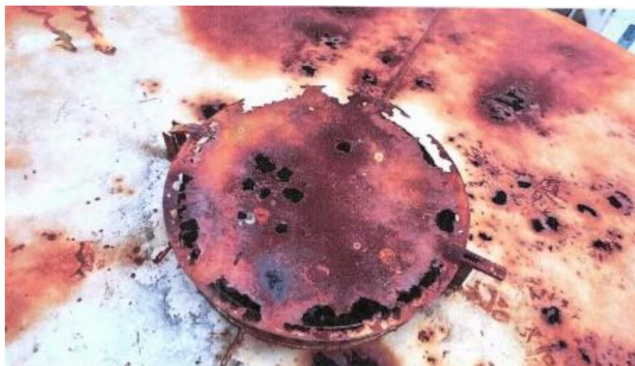
Imagem 3: vista superior do reservatório metálico
