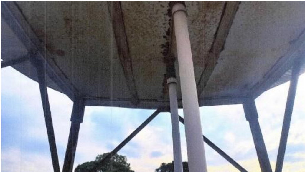
Imagem 4: base do reservatório metálico
