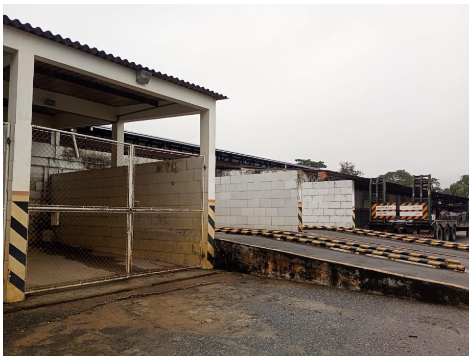
Foto 4 — Alvenaria exposta no acesso a um dos boxes
