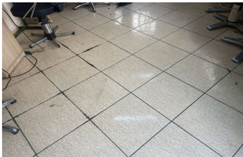
12. Piso da barbearia
