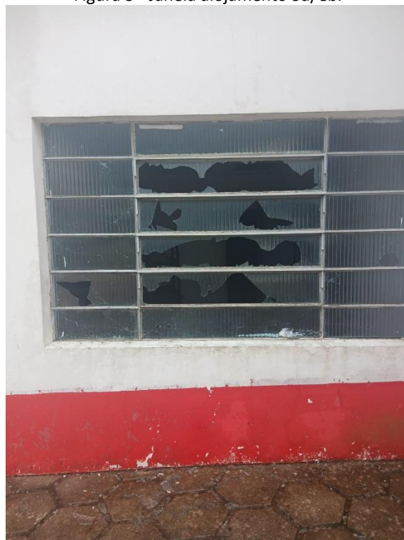
Figura 5 - Janela alojamento Sd/Cb.
