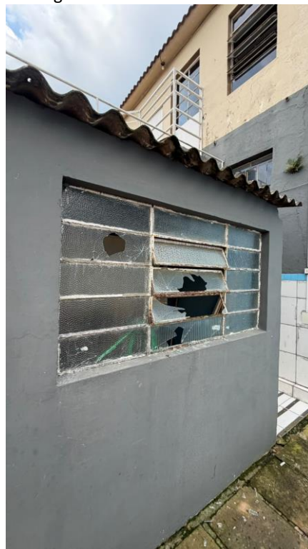
Figura 17 - Janelas danificadas.
