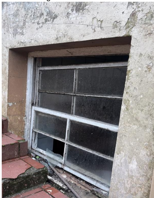
Figura 16 - Janelas danificadas.
