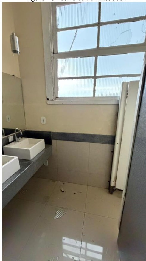
Figura 19 - Janelas danificadas.
