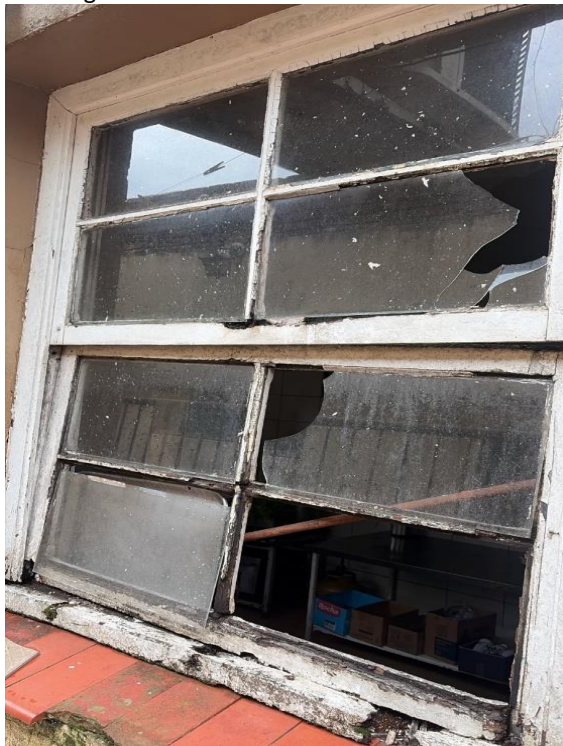
Figura 15 - Janelas danificadas.
