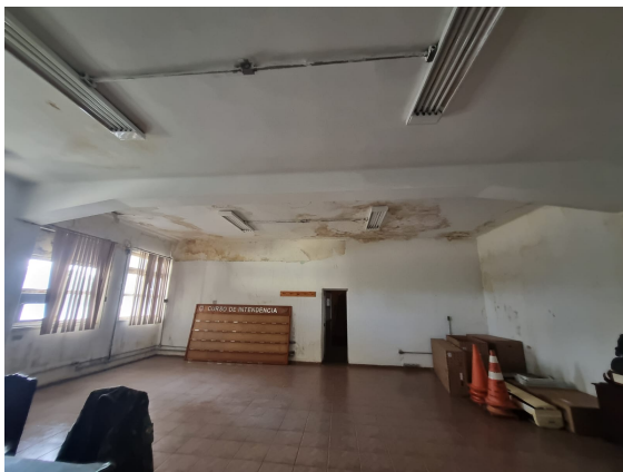
Registro fotográfico 1 – condições existentes nas salas da SECOD/C Log.
