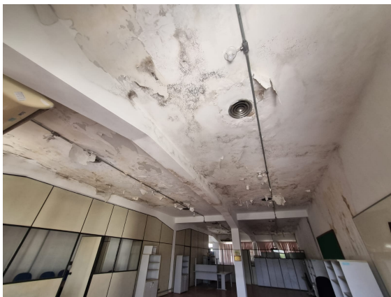
Registro fotográfico 5 – condições existentes nas salas da SECOD/C Log.
