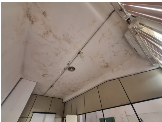
Registro fotográfico 3 – condições existentes nas salas da SECOD/C Log.
