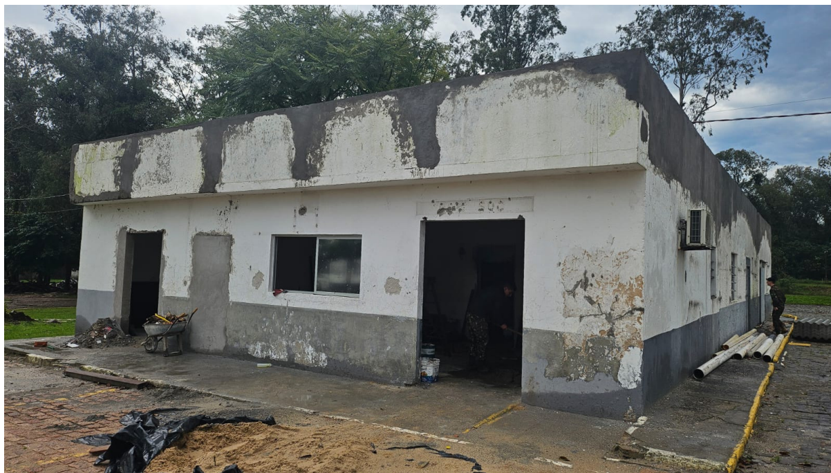
Foto 01. Benfeitoria em “reforma” para a instalação definitiva da Barbearia
