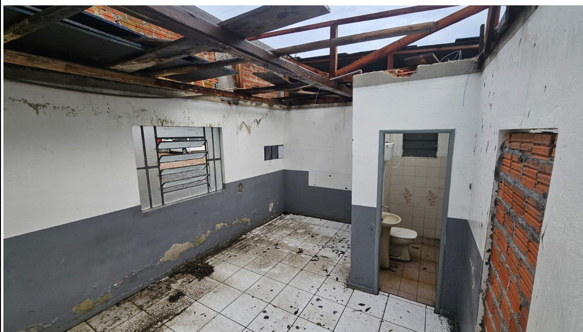
Foto 04. Fachada de acesso a sala da barbearia, local definitivo
