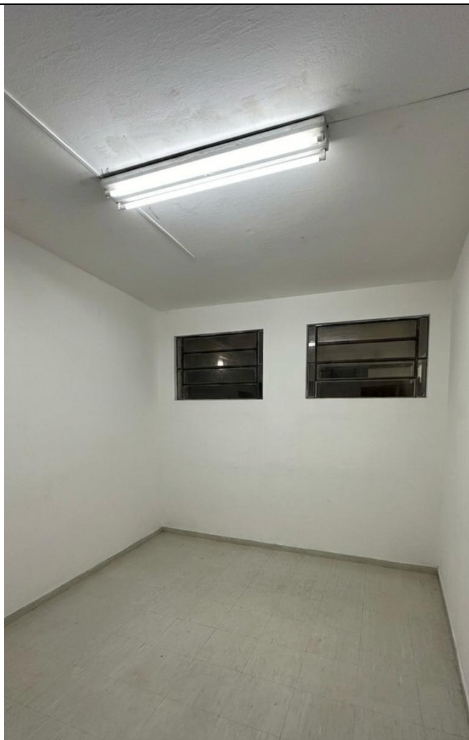
Foto 07. Benfeitoria localizada no Pav. Multiuso (Pav. Térreo) para uso da Barbearia-Local temporário
