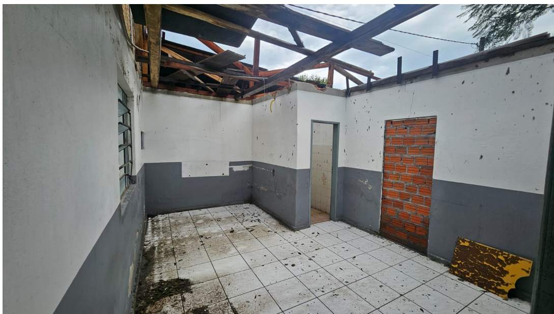
Foto 03. Benfeitoria em “reforma” para a instalação definitiva da Barbearia
