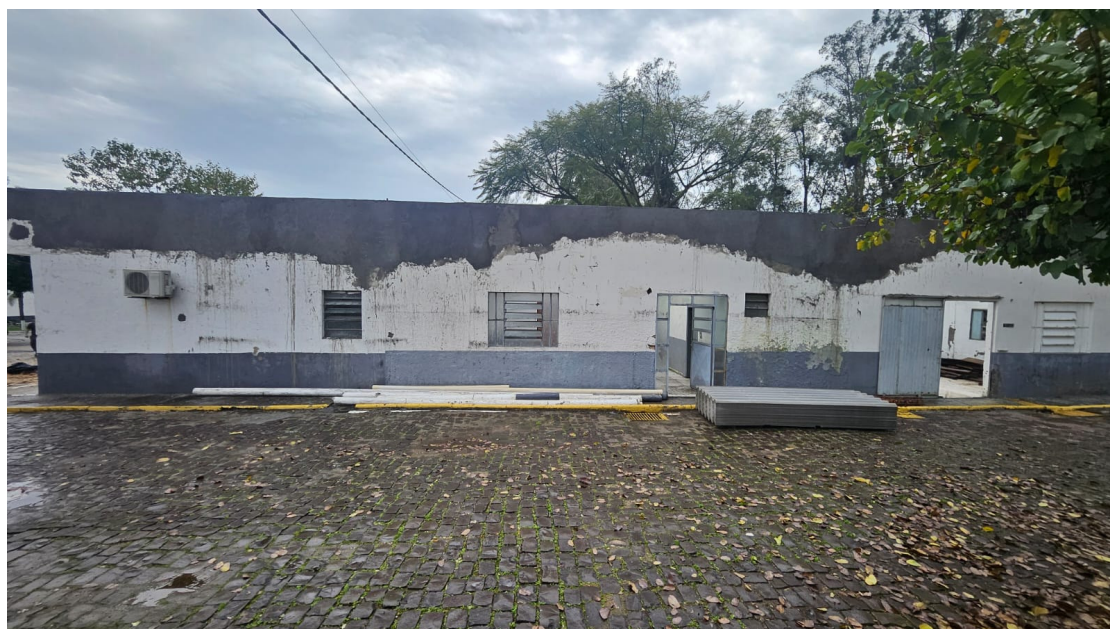
Foto 02. Fachada de acesso a sala da barbearia, local definitivo
