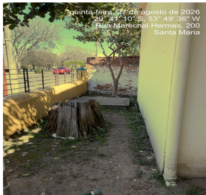
Figura 8 - Vista lateral da seção administrativa: piso intertravado a ser feito
