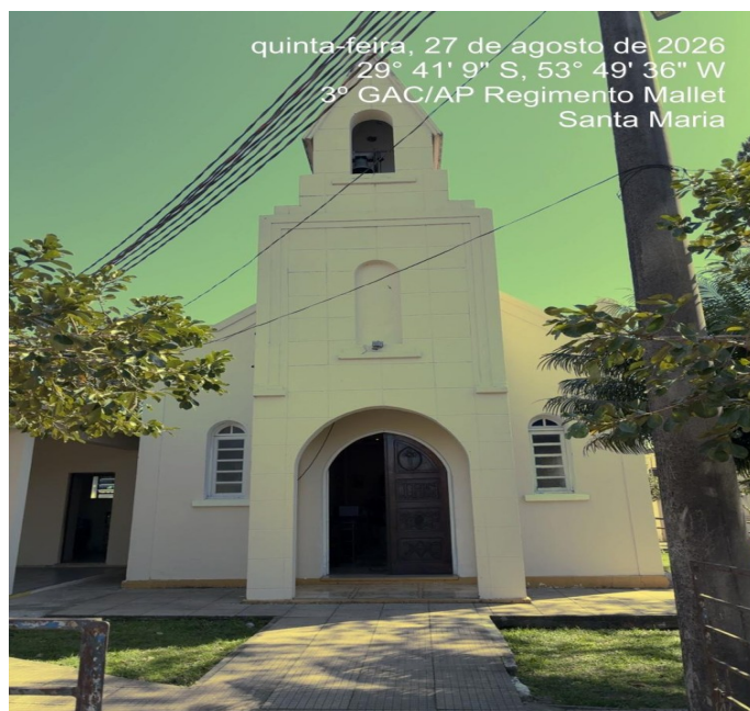
Figura 1 – Vista da Fachada frontal da Capela: refletor a substituir
