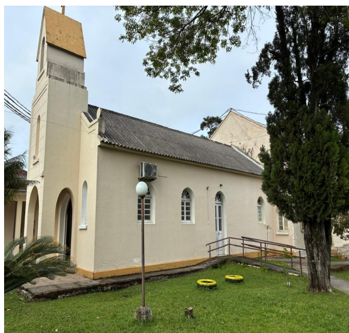
Figura 2 – Vista lateral da Capela: calçadas a pintar
