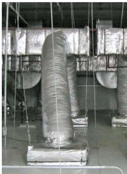
Figura 10 - Duto flexível de alumínio para conexões com caixa plenum
