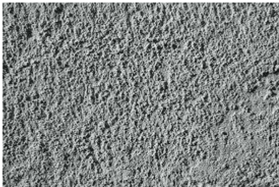
Figura 45 - Chapisco comum sobre alvenaria estrutural
