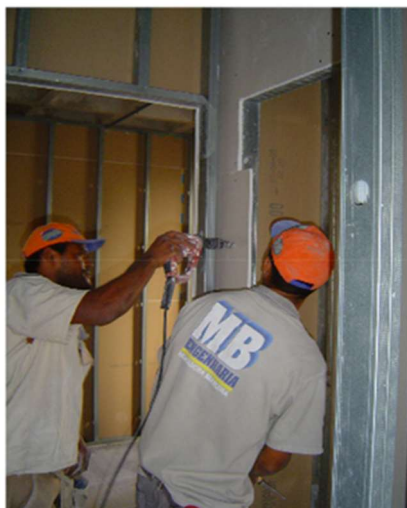
Figura 37 - Fixação das placas de gesso
