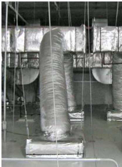
Figura 30 - Duto flexível de alumínio para conexões com caixa plenum
