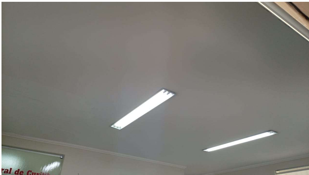
Figura 2 - Foto de forro a ser retirado
