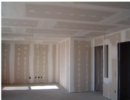
Figura 38 - Fita rejunte entre as placas
