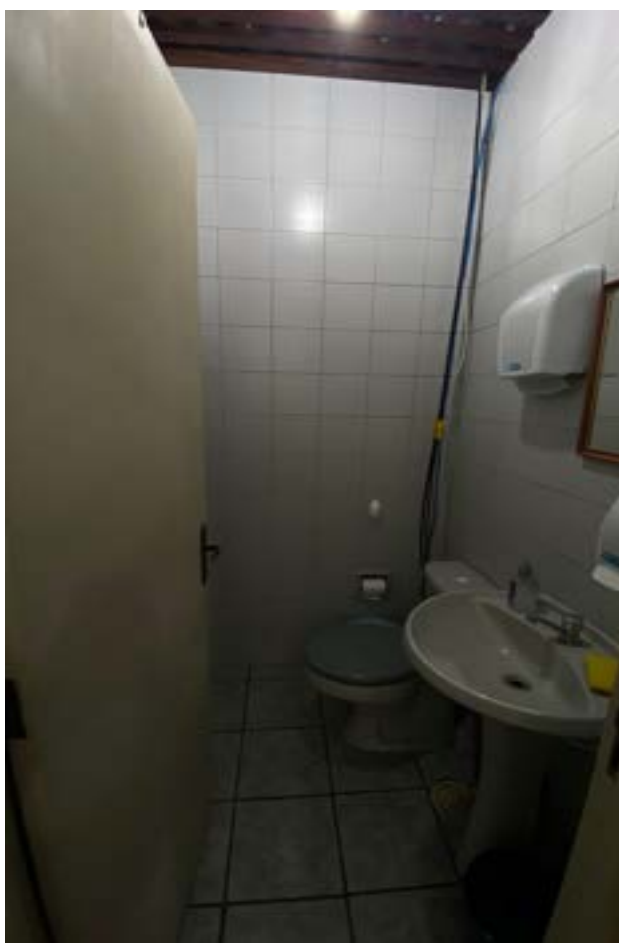
FIGURA 6 – VISTA DO BANHEIRO DA FHE
