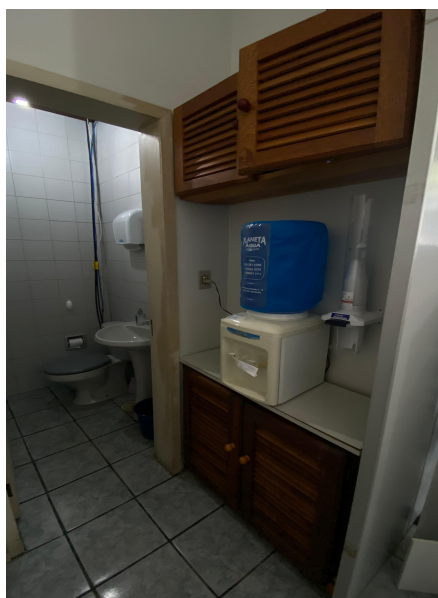
FIGURA 5 – VISTA DO CORREDOR, ARMÁRIOS E ACESSO AO BANHEIRO DA FHE
