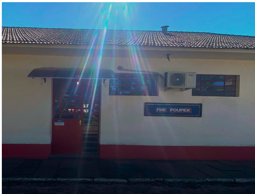
FIGURA 1 – VISTA APROXIMADA DA FACHADA DO ESCRITÓRIO FHE
