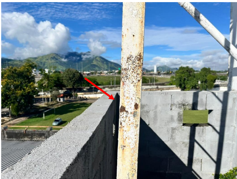
FOTO 8 – Diversos pontos da escada encontrassem com avançado estado de oxidação.
