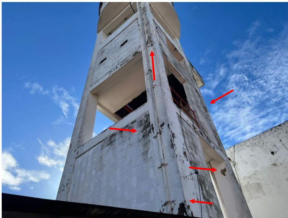
FOTO 4 – Vista aproximada do reservatório, podem ser observados diversos pontos da pintura deteriorada, expondo a estrutura ao desgaste.
