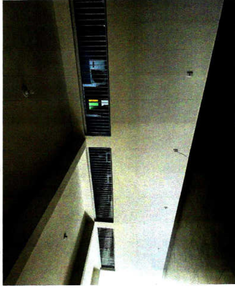
FOTO 15 – imagem das janelas laterais, à esquerda de quem entra na sala
