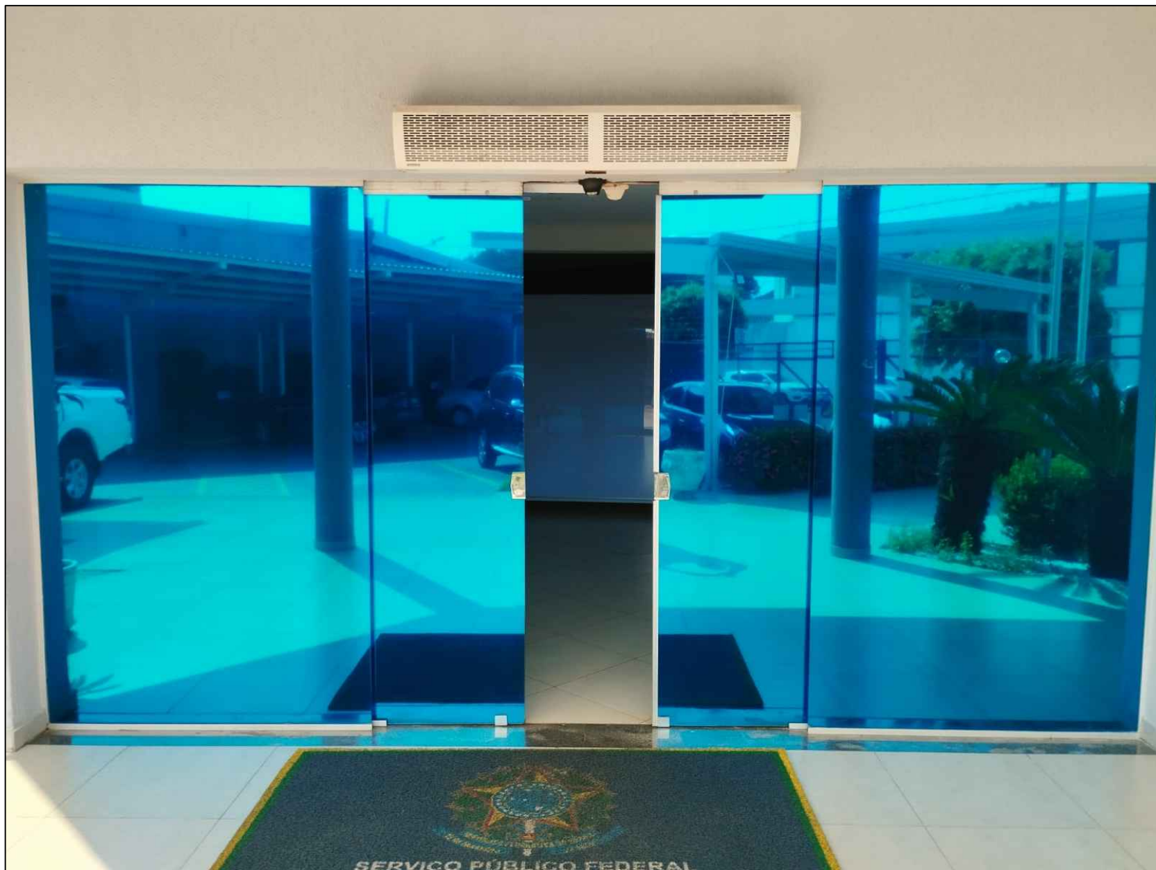
Imagem lado externo S/E
