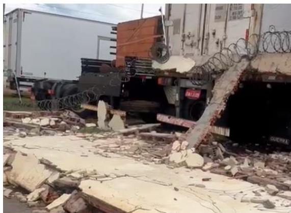
Figura 3 – Muro DMA Londrina PR
